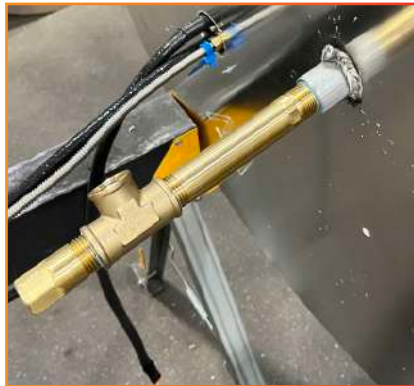
Foto 7: Instalación de la pierna de goteo
