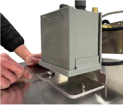
Foto 13: Montaje del transformador a la placa
